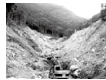
土石流の流下跡が残る崩壊現場(奈半利川)▶ P.27
